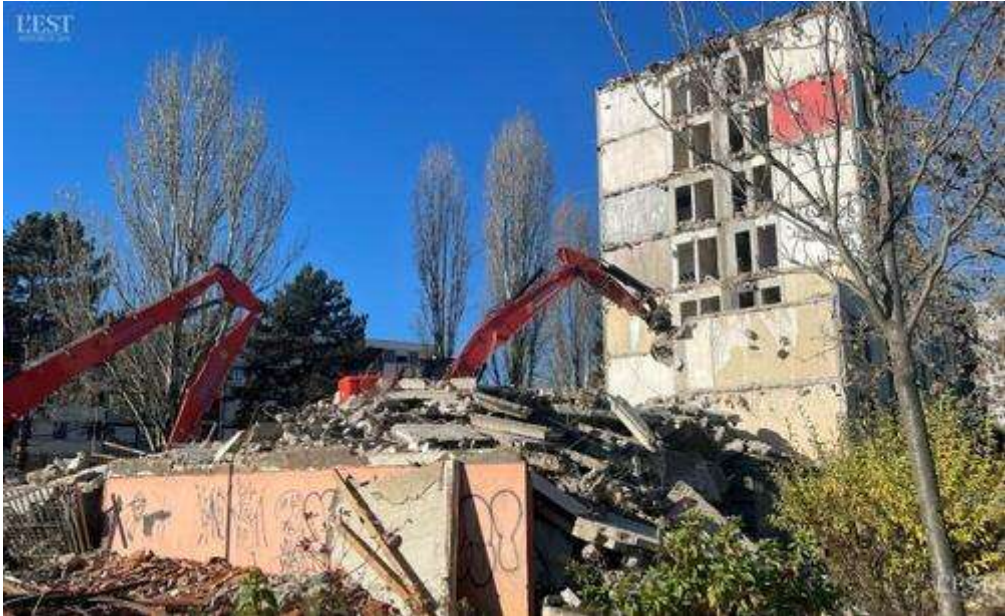
150 à 200 personnes ont été relogées par Batigère. Photo Frédérique Braconnot
